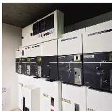
Cellules haute tension SM6 avec Sepam CEI 61850
